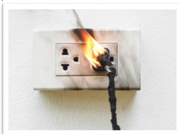
รูปที่ 2 อัคคีภัยจากอุปกรณ์ไฟฟ้าที่เก่าหรือไม่ได้มาตรฐาน
