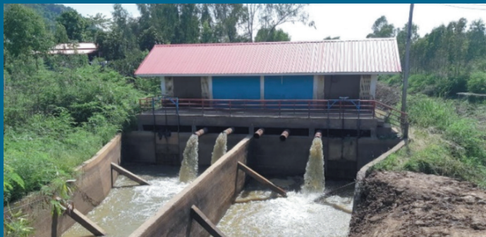
สถานีสูบน้ำย้อนกลับจากบึงบอระเพ็ด เพื่อสูบน้ำไปใช้ประโยชน์บริเวณที่สูง
